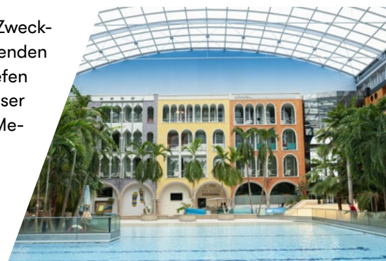
Im Versorgungsnetz der Geowärme Erding: die THERME ERDING
