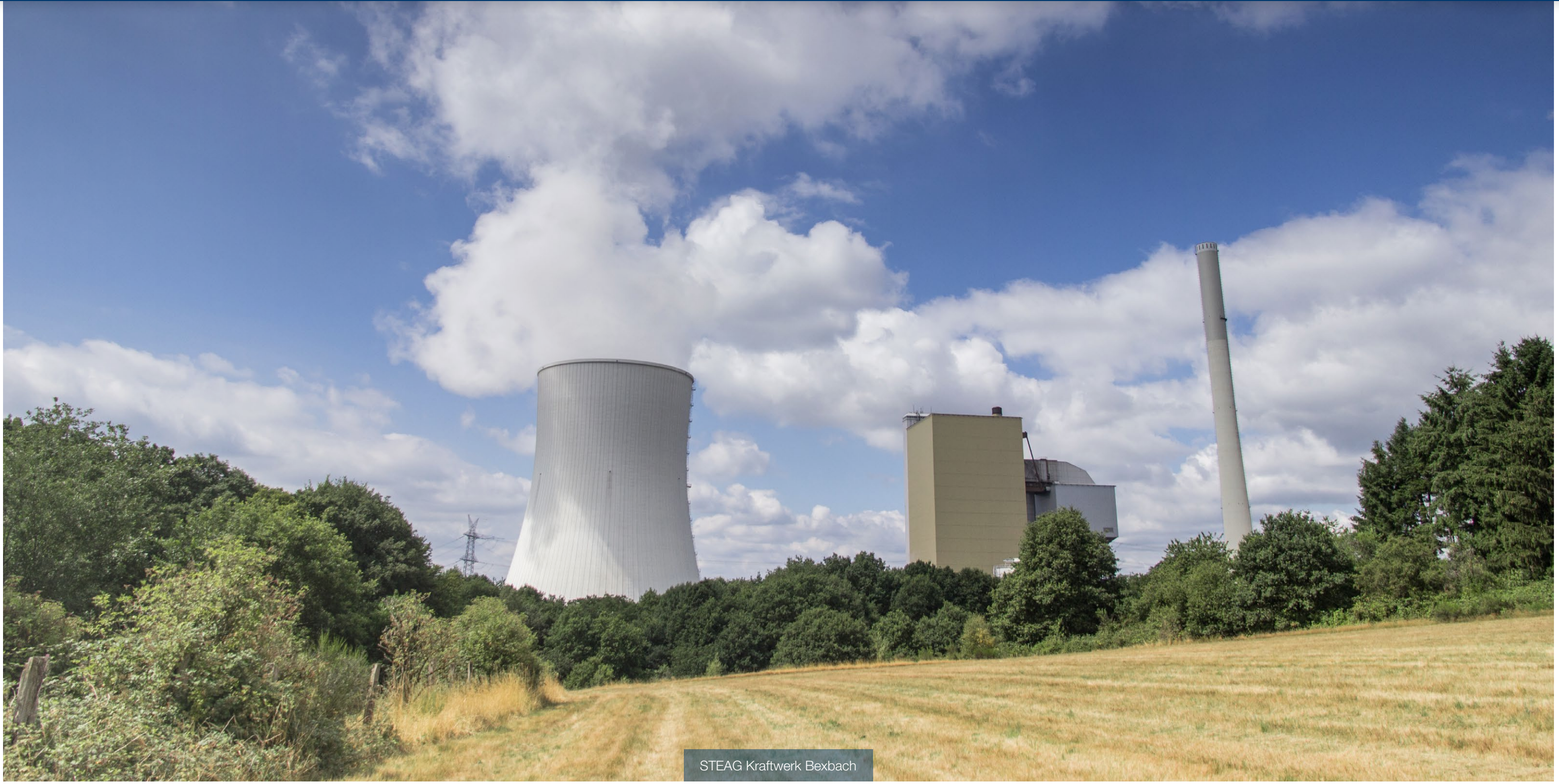
STEAG Kraftwerk Bexbach
